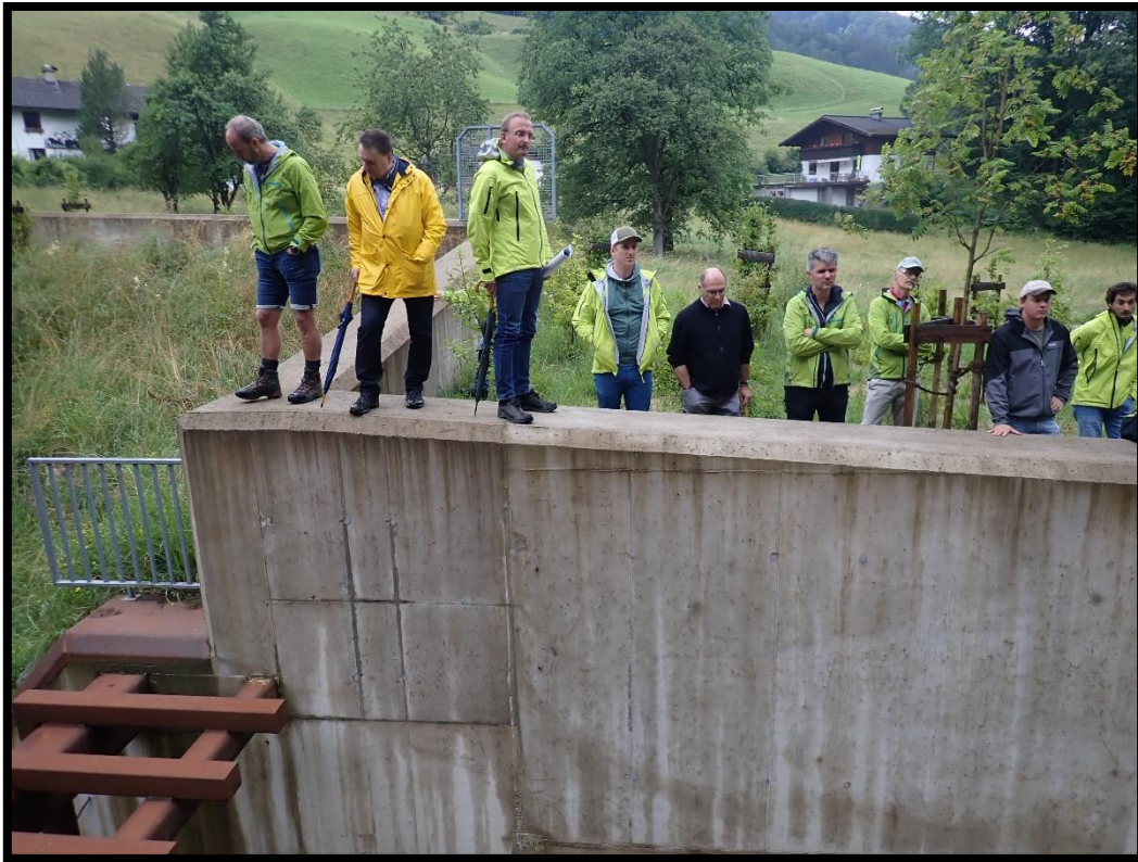
Abbildung 6: Die Kollegen bei der Begutachtung der Bauwerke (Foto: Reinhard Ribitsch)
