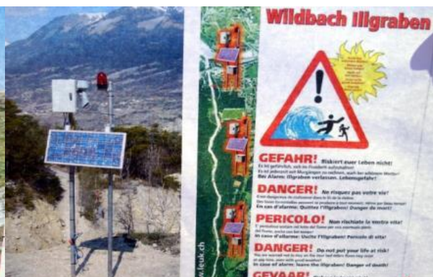
Abbildung 25: Akustische und Visuelle Warneinrichtungen im Illgraben © WSL
