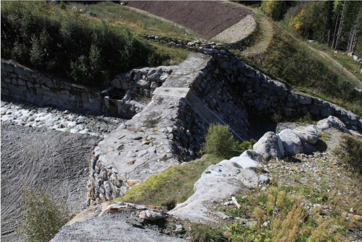
Abbildung 12: Taconnaz; Geschieberückhalteanlage und Lawinenauffangdamm (© Ribitsch)
