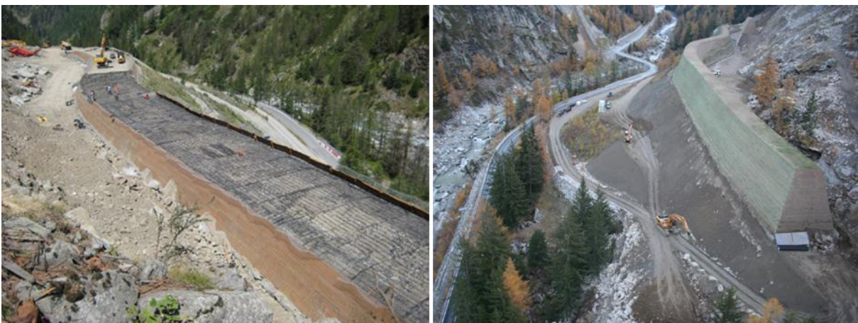
Abbildung 5: Steinschlagschutzdamm in Arbeit (links) und fertiggestellt (rechts)
