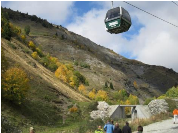
Abbildung 15: Geschiebesperre am Grabenausgang mit integriertem Auslass des Bypassstunnels.
