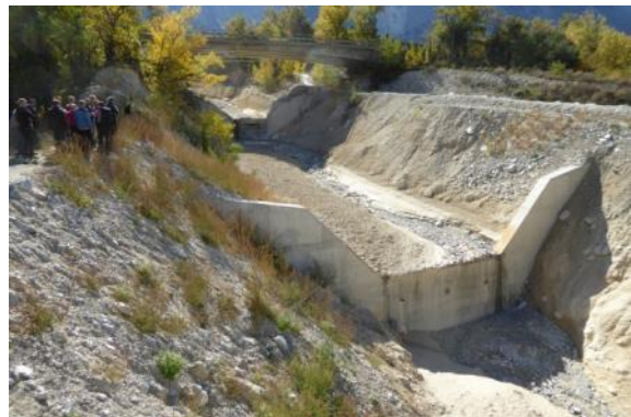
Abbildung 23: Mündungsstrecke Illgraben mit Kantonsstraßenbrücke © Schilcher
