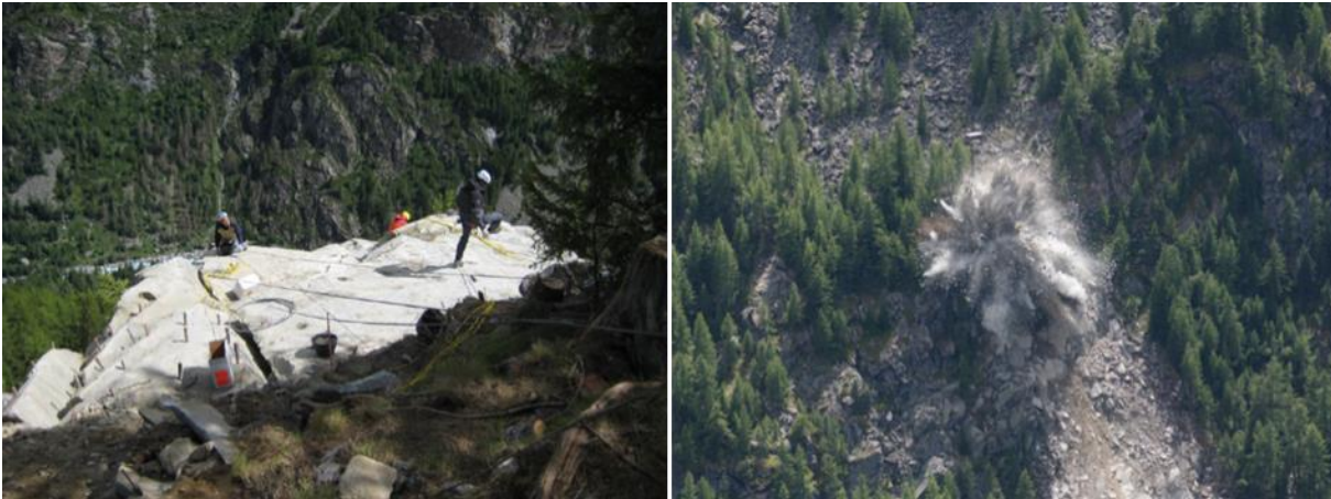
Abbildung 4: Sprengarbeiten im Abbruchbereich
